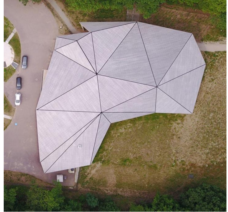
Roof Vitens Zeddam (Olster dakwerken)
